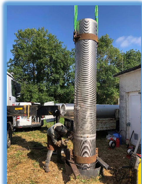
Réhabilitation du forage de Grand Bois Battu à Vernoux-sur-Boutonne
