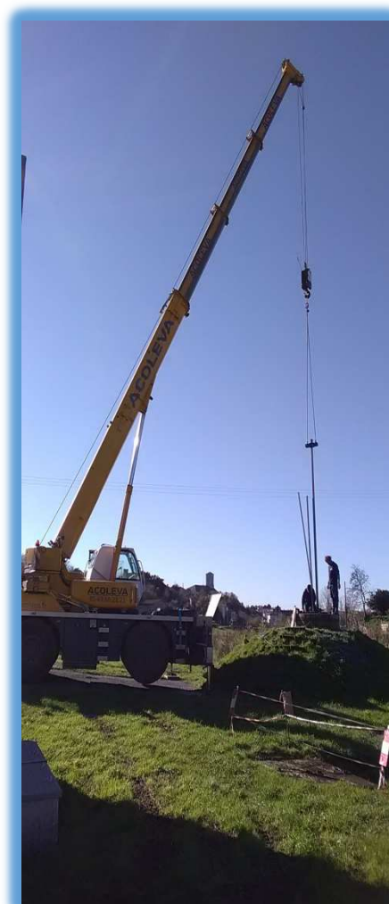
Renouvellement d'une pompe du forage de Coupeaume 3 à Chef-Boutonne
