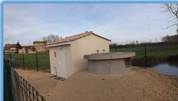
Le captage du Boulassier à Périgné
