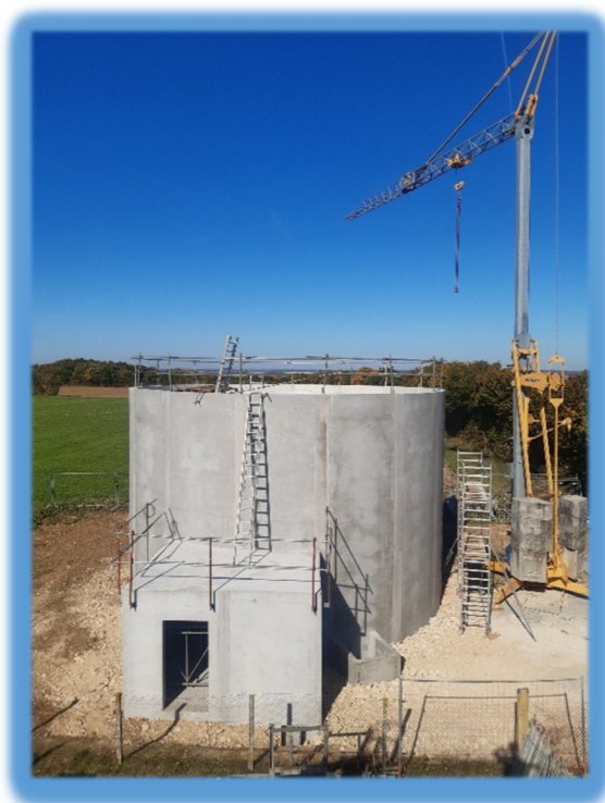
Construction de la cuve n°2 de la Bataille – Chef Boutonne
