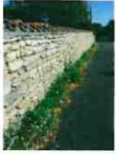
Mur enherbé dans la ville
